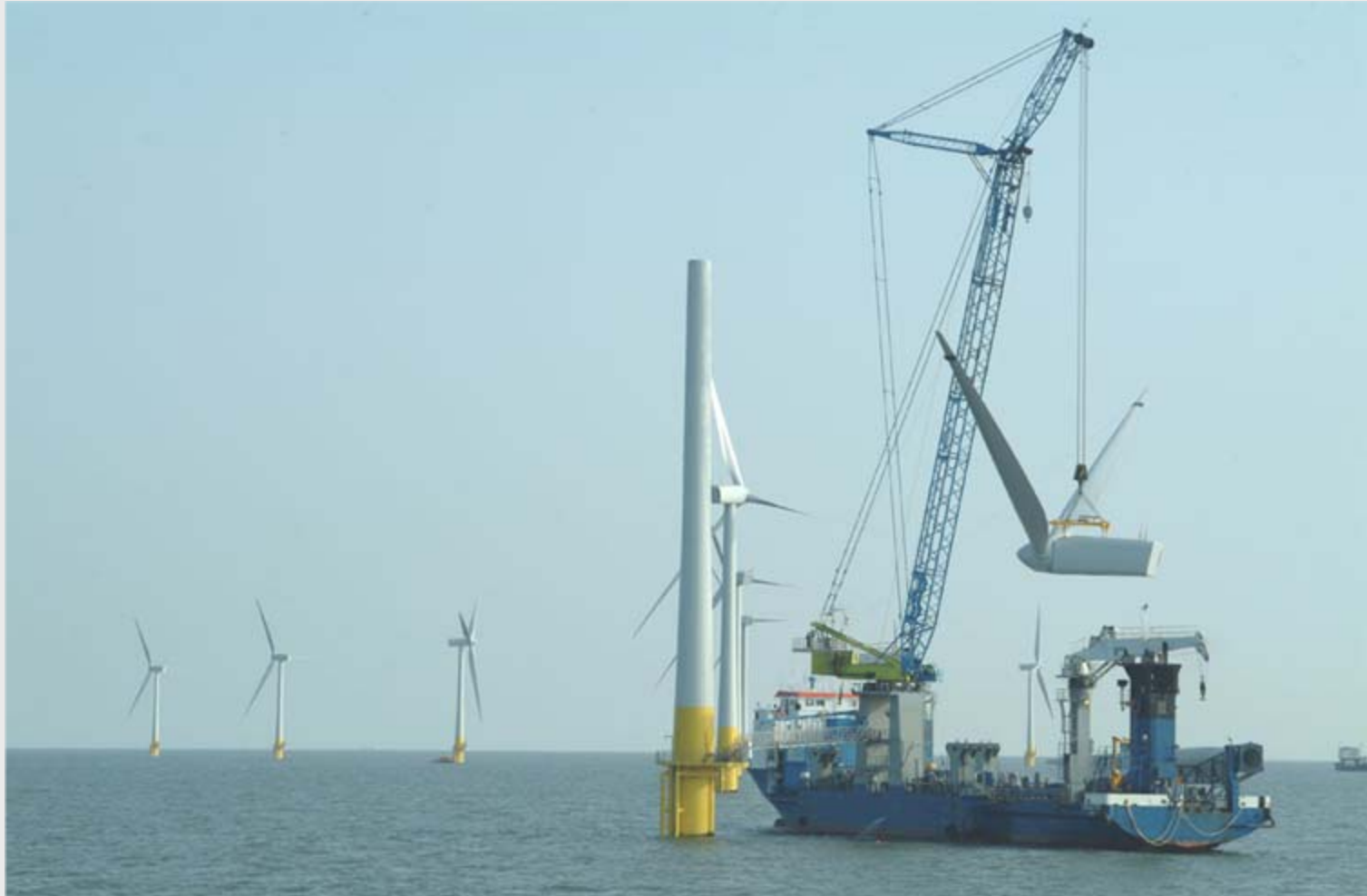
Navire spécialisé A2SEA - Eoliennes de 2MW – Scroby Sands (UK)
