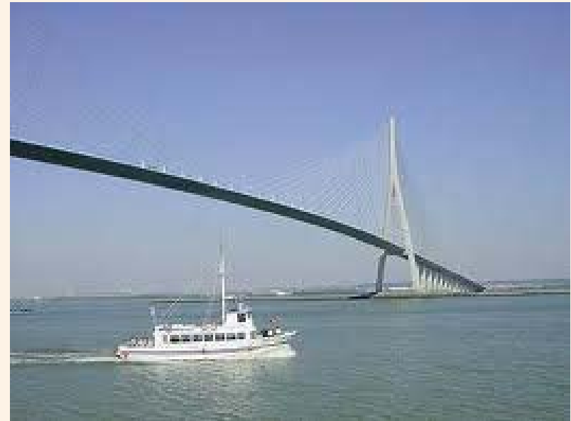
Le pont de Normandie
