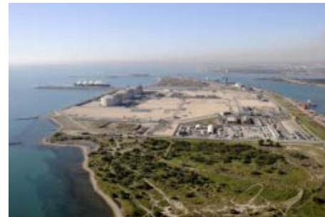
Fos Cavaou LNG terminal, France
