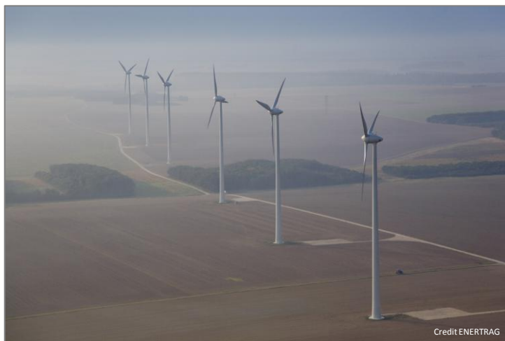
Parc éolien de Chemin de Tuleras (2007) : 6 éoliennes de 2 MW
