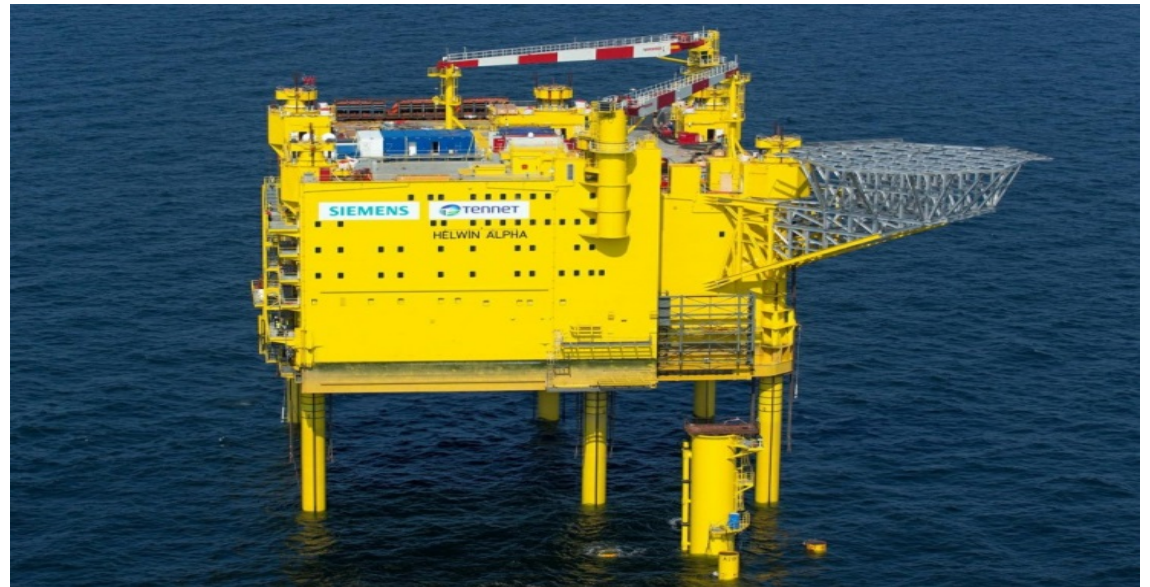
Plateforme transformateur DC (Helwin alpha – 500MW) 10000t
