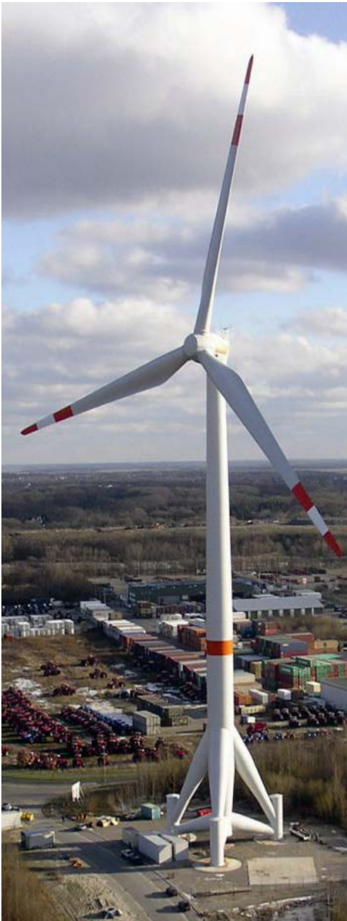
Eolienne offshore 5MW ( prototype à terre ) Environ 1000 t et 130m de hauteur (selon le site)
