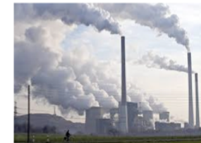
Centrales électriques gaz/oil
