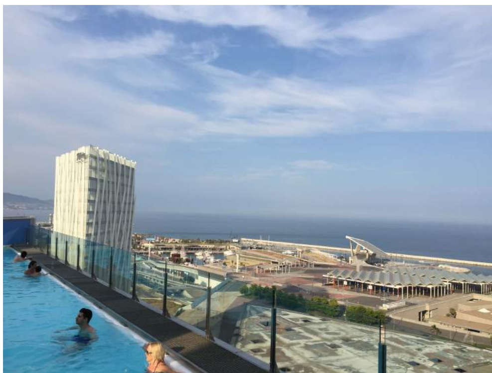
2. Vue depuis la piscine de l'hôtel Barcelona Princess. On observe le toit du forum triangulaire d'Herzog & de Meuron au premier plan, la marina à gauche, les installations solaires à droite avec le panneau monumental d'où part la passerelle en fond. (Bouton, 2015)
